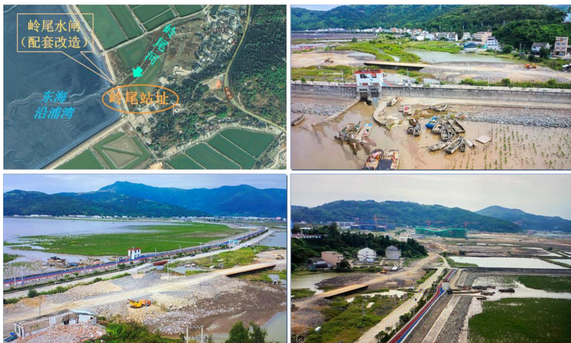
图 2.2-6 岭尾水闸现状
