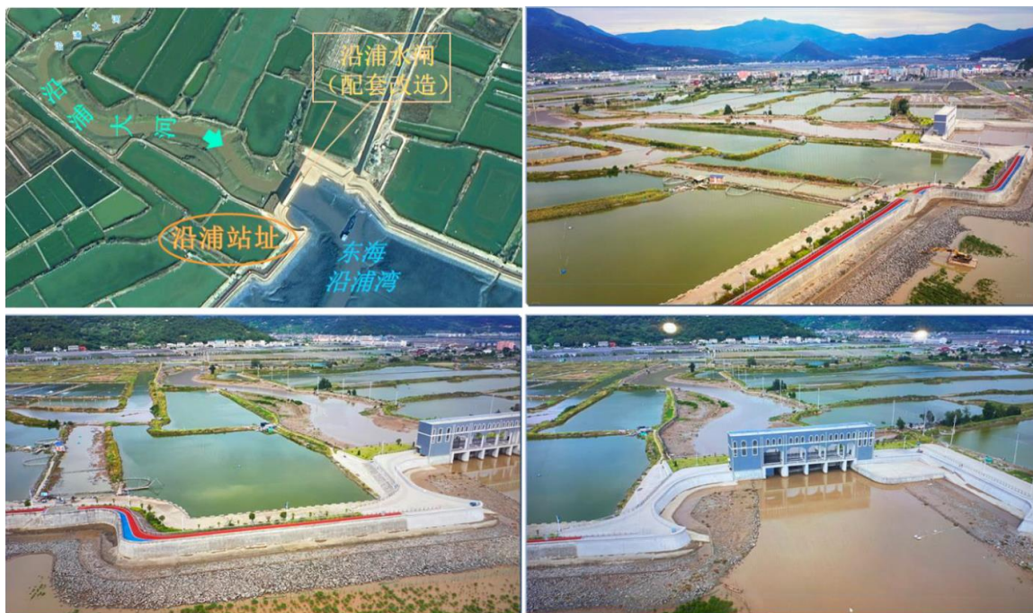
图 2.2-4 沿浦水闸现状
