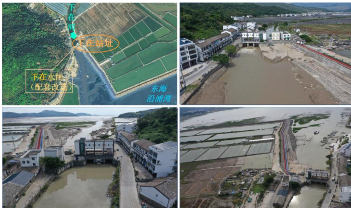
图 2.2-5 下在水闸现状
