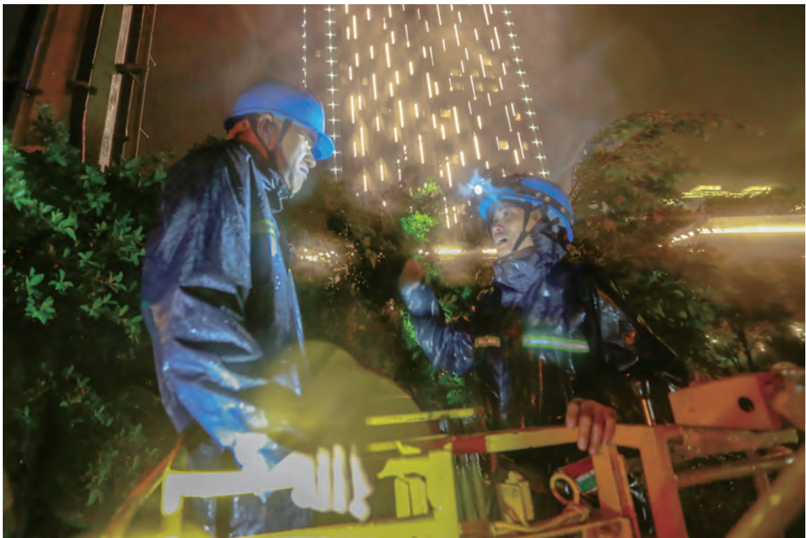
抗击“利奇马”台风,电力工人抢修受损设施。(县供电局供稿)
