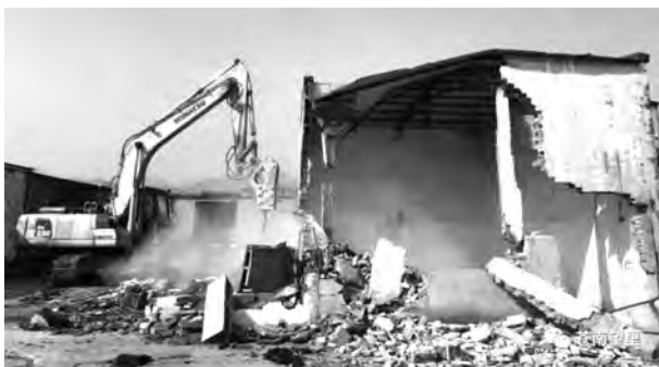
3月12日,望里镇对浣底园一下堡片区的违章厂房进行集中拆除
