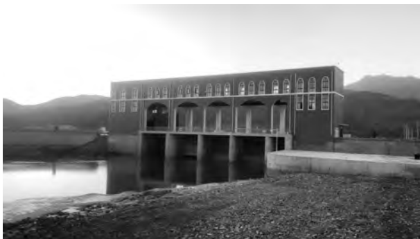
8月30日,沿浦水闸通过通水验收
