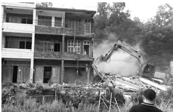
绿能小镇南部区块59间房屋拆除现场
