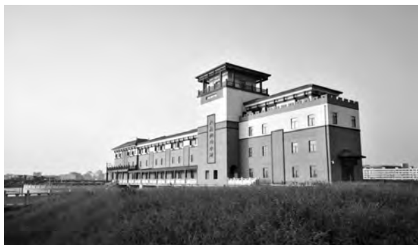
6月6日,舥艚水闸通过通水阶段验收
