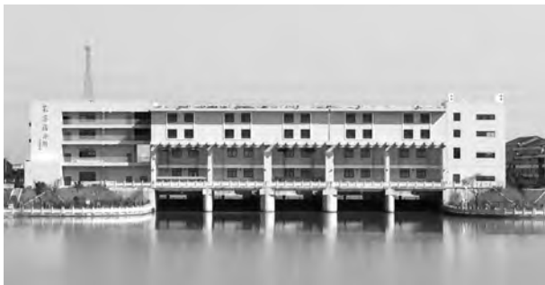
10月24日,朱家站水闸除险加固工程通过竣工验收
