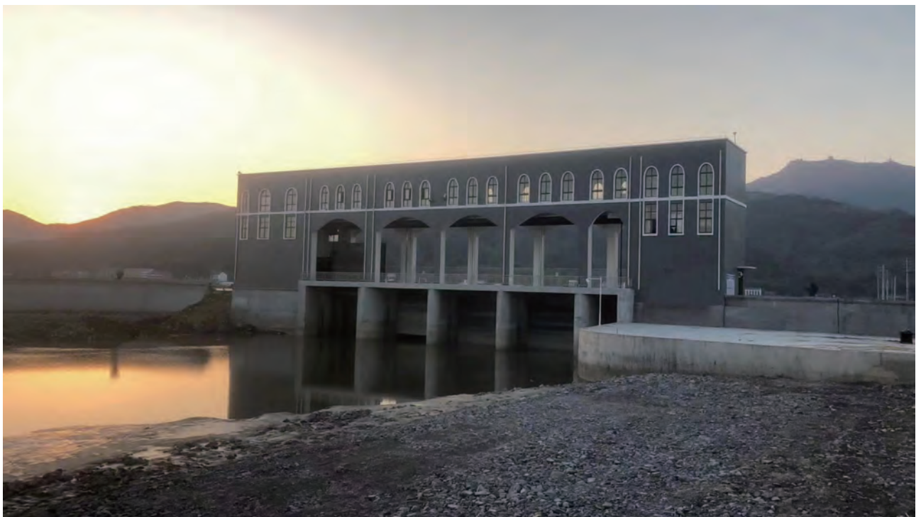
沿浦水闸。(县水利局供)
